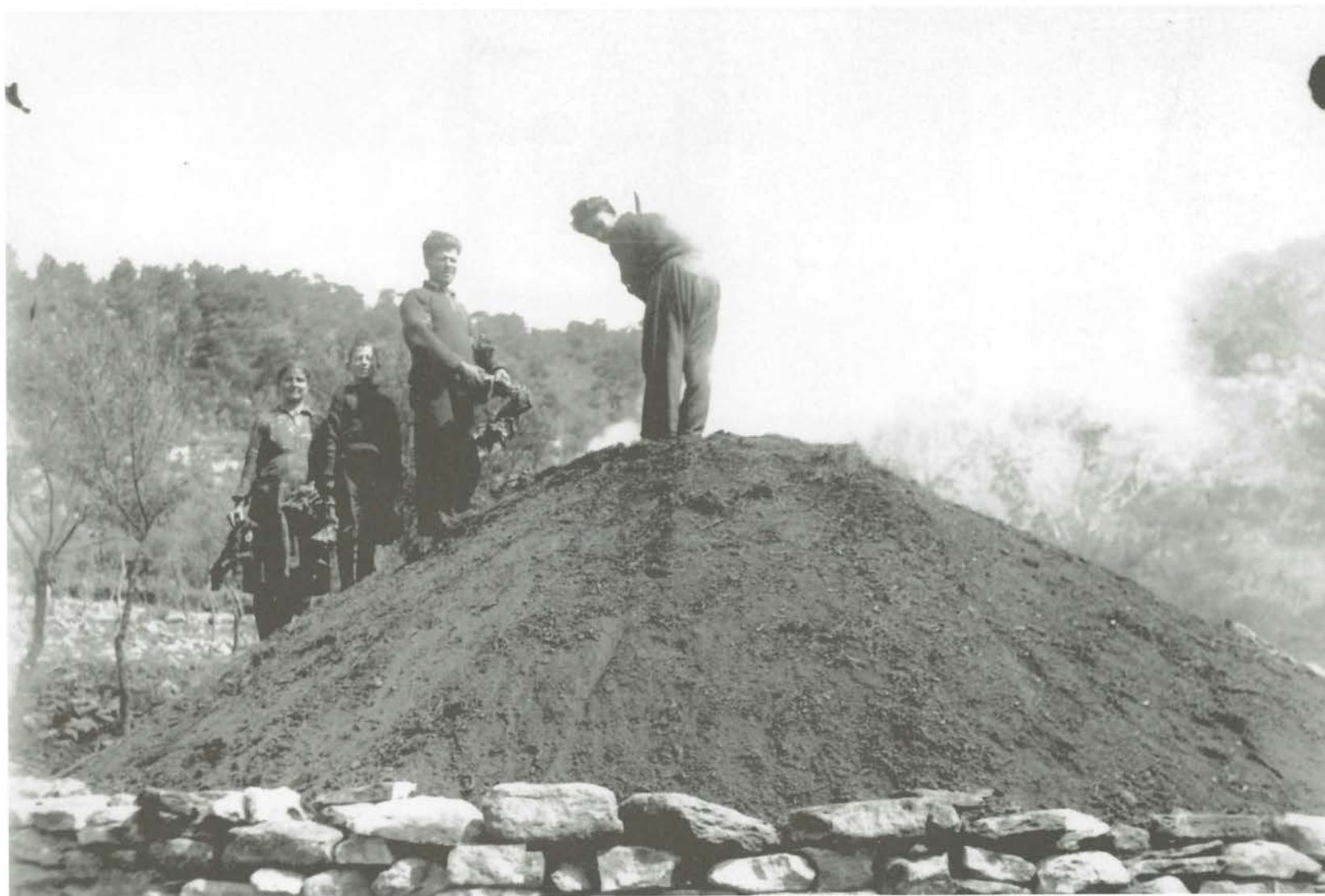
Κατασκευή καμινιού κάρβουνου, αρχές δεκαετίας του 1930
