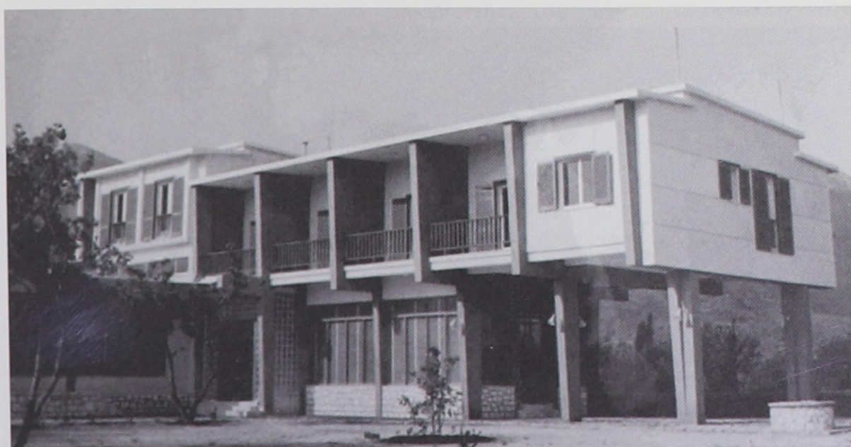
Το κτιριακό συγκρότημα του «ΞΕΝΙΑ» στο Λιμένα της Θάσου την δεκαετία του 1960 έτοιμο να δεχθεί τους επισκέπτες του νησιού.
