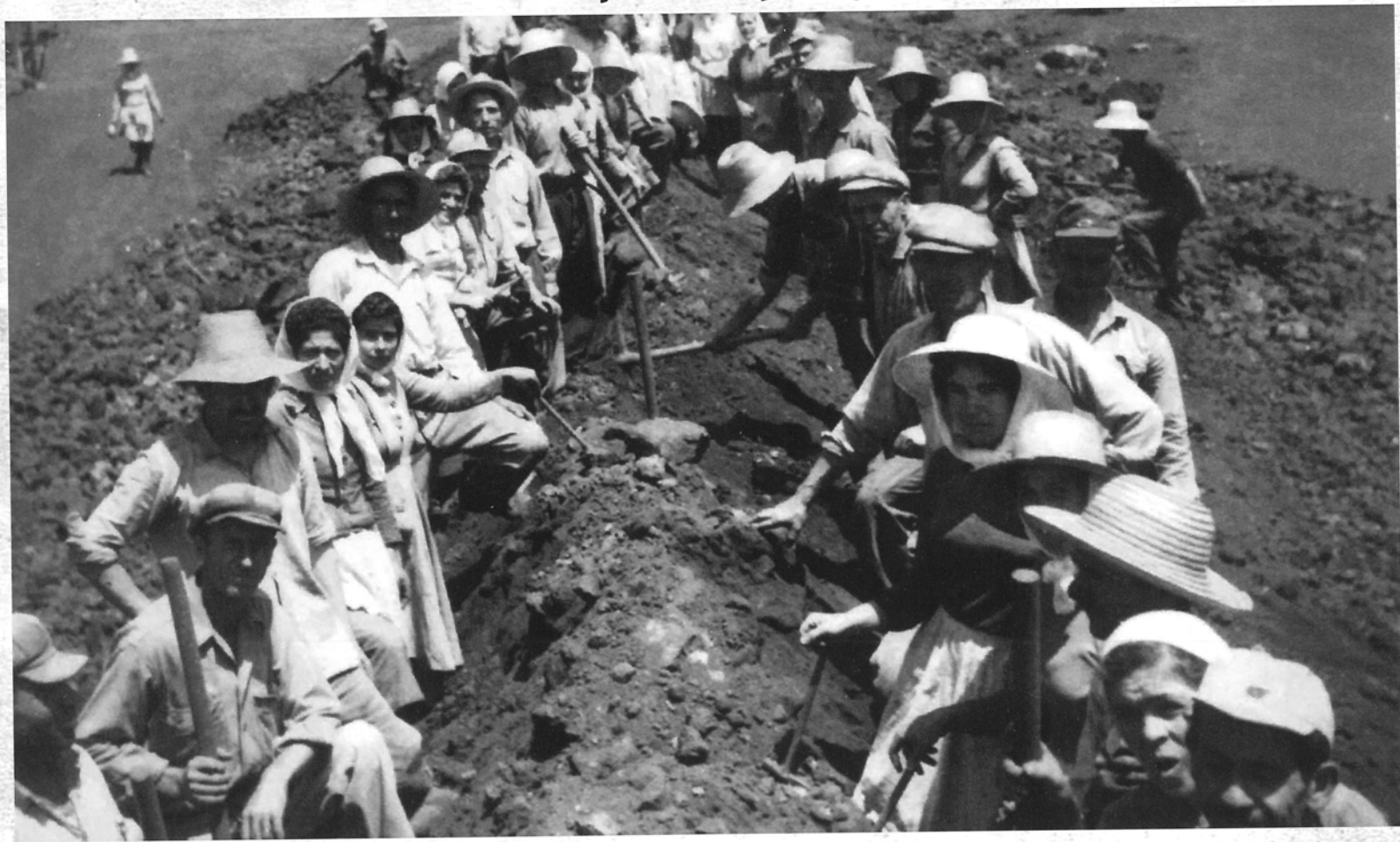
Εργάτες και εργάτριες στο «Μαυρόλακα», Λιμενάρια 1957
